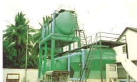
ติดตั้งยก (POWER TANK) : ศูนย์การค้า SAVE ONE งามวงศ์มาศ
