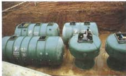
ติดตั้งลอยบนผิวน้ำ (GROUND LEVEL) : หนองพิกุล ๑, พิกุล ๒
